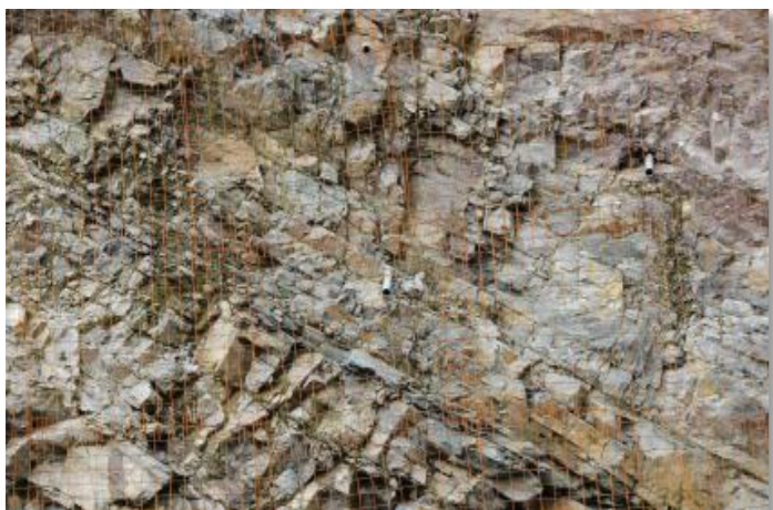
(3) 보강용 철망 설치
